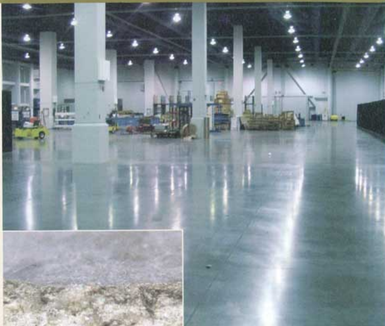
Abb. 6 und 7: Mit modifiziertem Natriumsilikat veredelter Beton. Die Oberfläche ist geschlossen, verfestigt und staubfrei.
